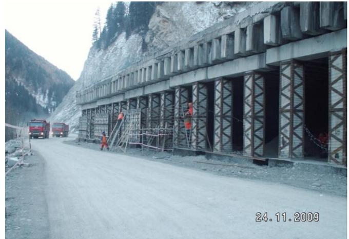
Рис. 1. Процесс усиления фундамента и опор
