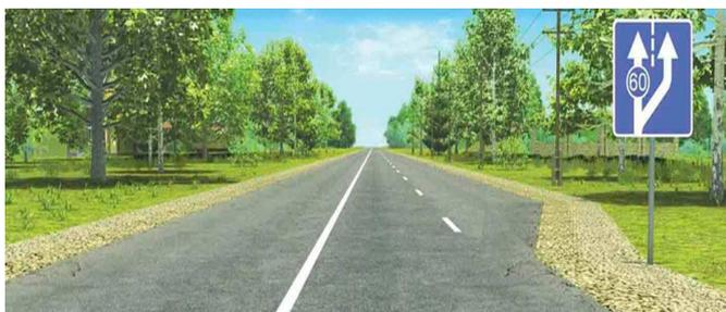
Рис. 2. Полоса для обгона транспортных средств на подъеме
